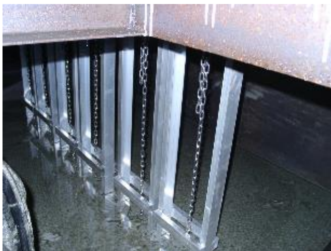
オイルアタッカー設置後のタンク内状態
